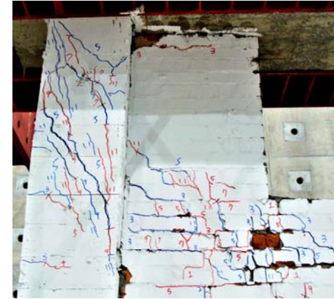
側位移比1.5%，邊柱剪力裂縫快速發展
