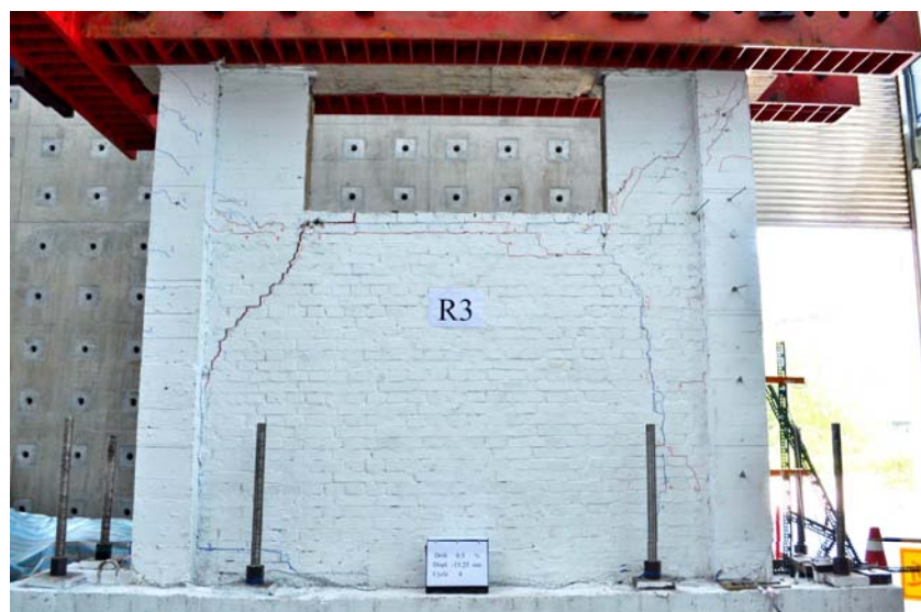
側位移比0.5%，牆體受壓產生水平向裂隙、而受拉產生垂直向裂隙
